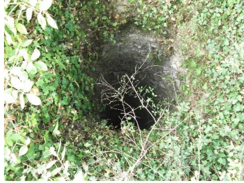
Cheminée d'aération de la cavité. ©Biotope
