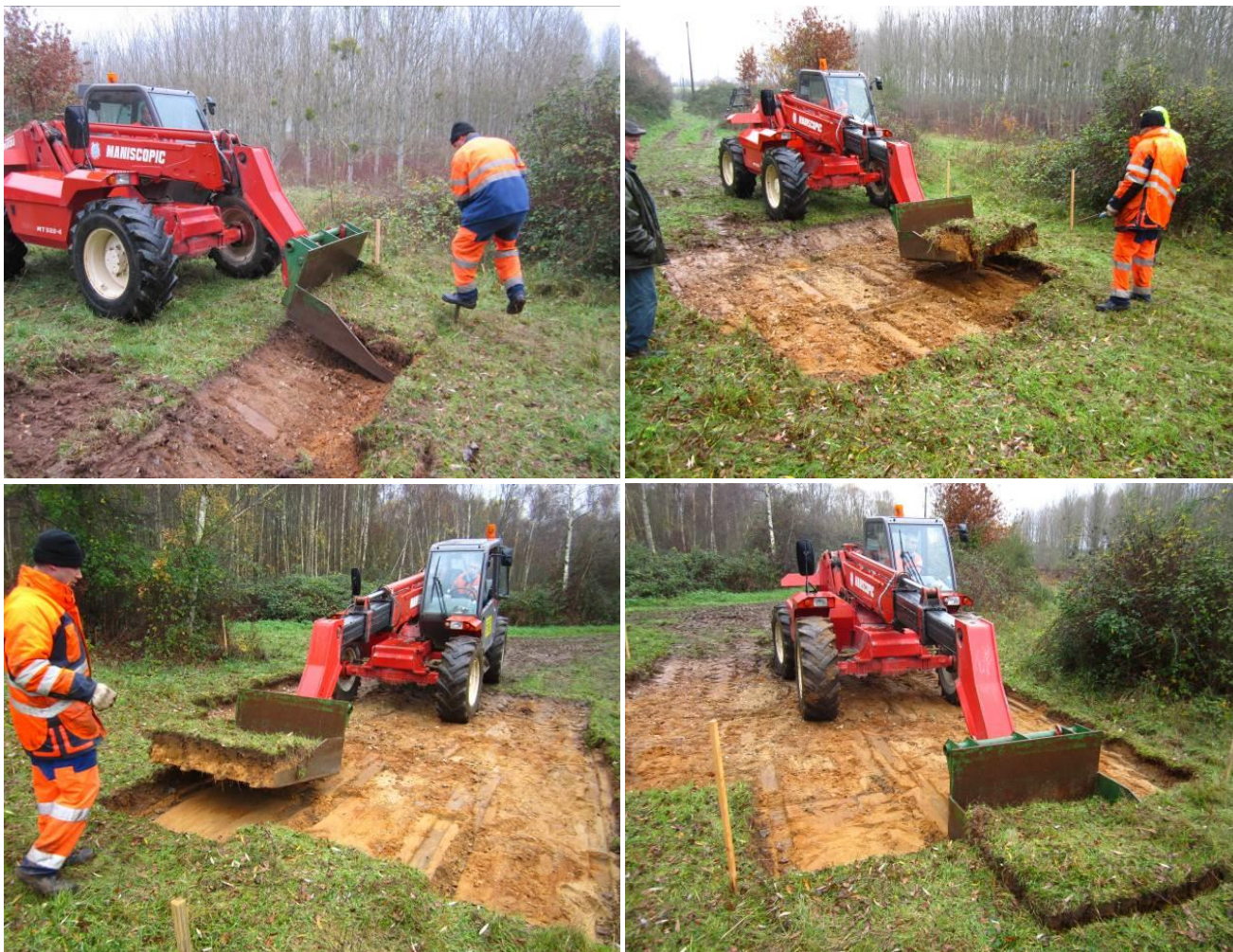
Exemple de découpages et prélèvements successifs par plaques de végétation © OGE
