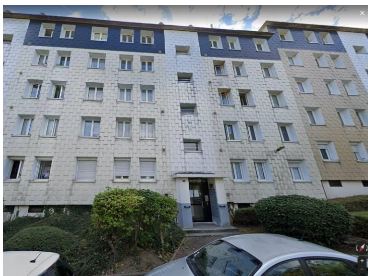
Les accès halls aux bâtiments H et E sont situés côté rue Source : Immobilière 3F
