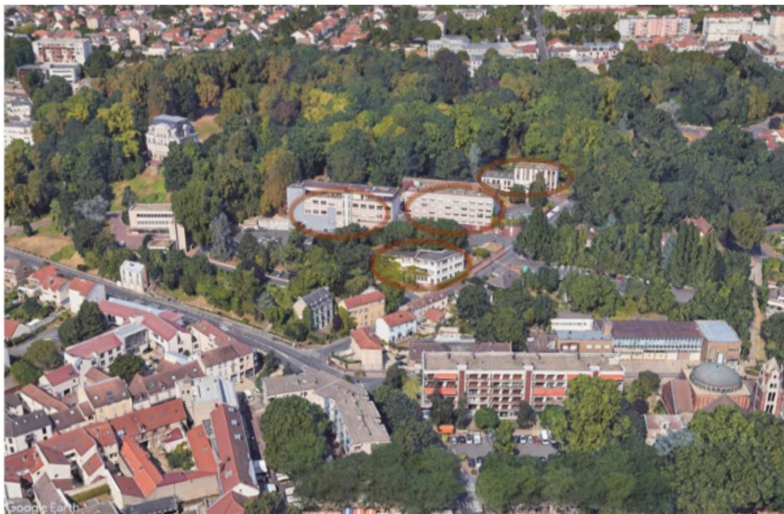
Figure 104 : Vue d'ensemble des bâtiments existants et identification des bâtiments à démolir (cerclage rouge)
