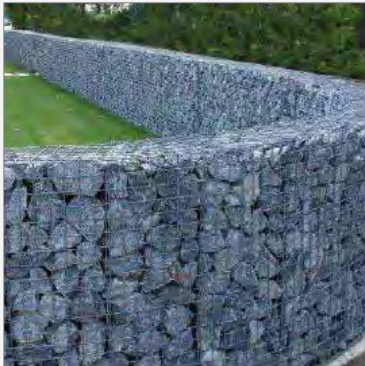
Figure 100 : Exemple d'un aménagement de gabion
