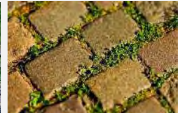
Pavement à larges joints
