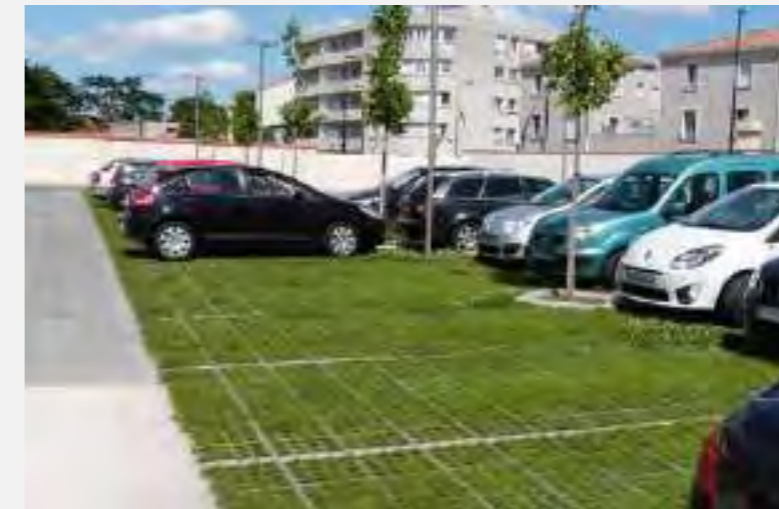
Parkings perméables végétalisés
