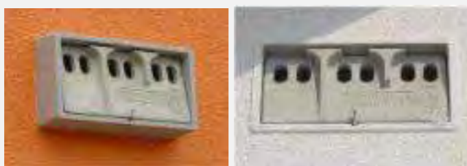
Exemples de nichoirs simples pour le Moineau domestique : peut être fixé sur le mur et partiellement enchâssé dans l'isolation, ou encastré complètement dans la construction, il remplace alors un parpaing et affleure la façade
