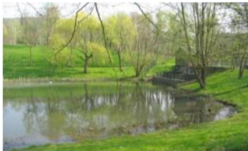
Le Bassin des Damoiseaux Capacité : 37 000 m 3 (Igny)
