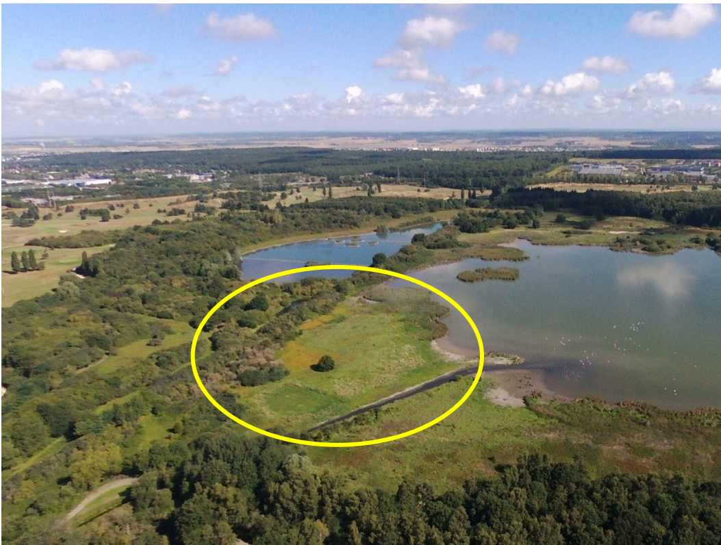
□ Photographie aérienne : survol de la roselière ouest après travaux 2016 ; aout 2017
