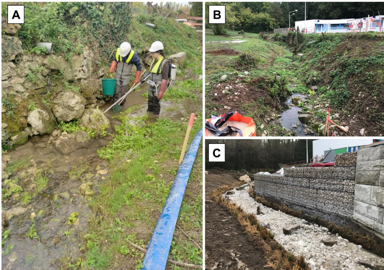
Figure 2 : A : pêche de sauvetage réalisée sur le ru de Bellot le 13 octobre 2022 ; B : ru de Bellot avant travaux ; C : ru de Bellot après travaux de restauration en décembre 2022
