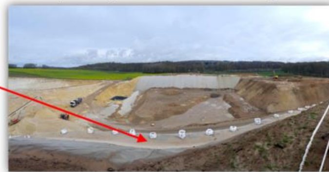
Vue panoramique du casier Nord en cours d'exploitation
