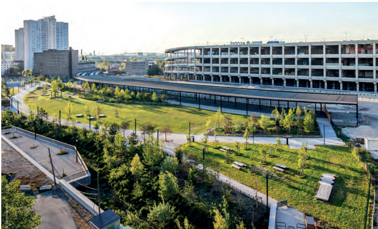
Vue de la ZAC Chapelle-Charbon (Paris 18 e ), située entre les portes de la Chapelle et d'Aubervilliers
