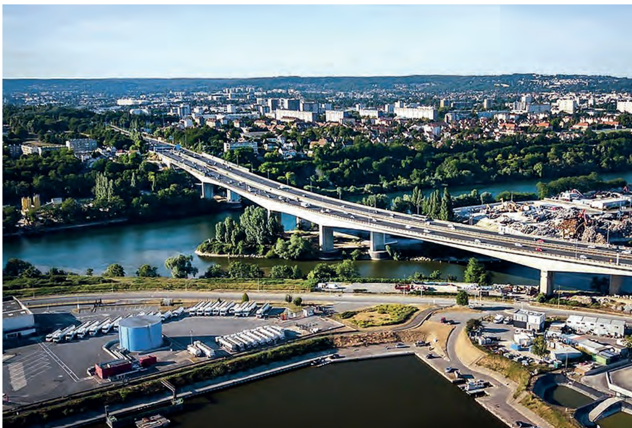
Opération d'aménagement du quartier de la Porte Saint-Germain - Berges de Seine à Argenteuil (Val d'Oise)
