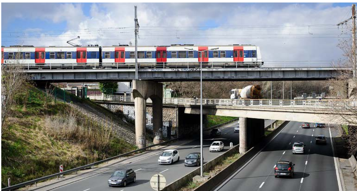
Croisement de voies autoroutières (A6) et ferrées (RER B) à Gentilly | Crédit photo : Arnaud Bouissou - Terra
