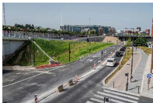
Travaux de réaménagement de l'échangeur Pleyel | Crédit photo : Sylvain Cambon
