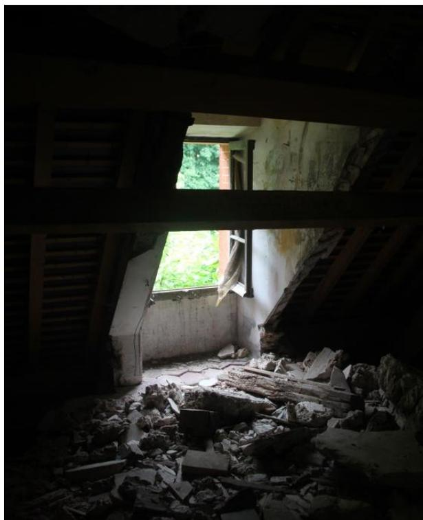
**Photographie 13 : Zone de toiture effondrée au bout du couloir donnant sur le comble où se trouve la colonie (vue intérieure)**
