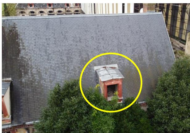
**Photographie 15 : Zone de toiture effondrée au bout du couloir donnant sur le comble où se trouve la colonie (vue extérieure)**
