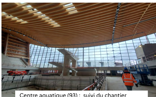
Centre aquatique (93) : suivi du chantier olympique et de sa livraison.
