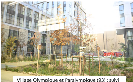
Village Olympique et Paralympique (93) : suivi du chantier olympique et de sa livraison.
