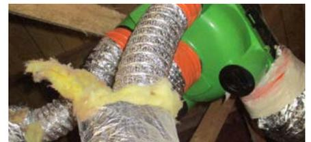
**Gainés du circuit de ventilation mal assemblés ou percés**, la ventilation des logements ne peut pas se faire de manière correcte et permanente.
