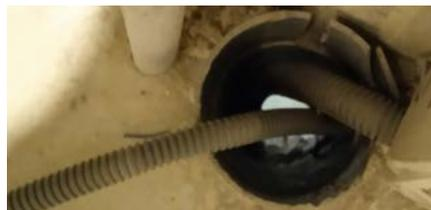
**Absence du recouvrement au niveau du passage de gaines entre le parking en sous-sol et le rez-de-chaussée** : si un incendie se déclare, le feu se propagera plus rapidement entre les deux étages.
