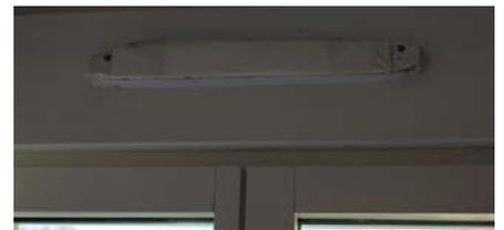
**Entrée d'air bouchée** : l'air du logement n'est donc pas renouvelé correctement.
