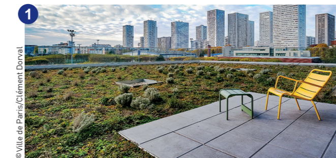
1 Strate extensive, sur le toit d'un bâtiment avenue de la Porte d'Ivry (13 e ). Végétation rase de type mousses, plantes succulentes, graminées. Le substrat est léger et de faible épaisseur : 8 à 12 cm. Charge induite : 80 à 150 kg/m 2 .
