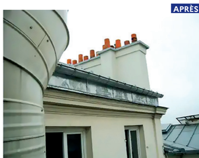
Après le sarking : la gouttière et la corniche sont séparées par la sur-hauteur due à l'épaisseur de l'isolation. La sur-hauteur est habillée de zinc.
