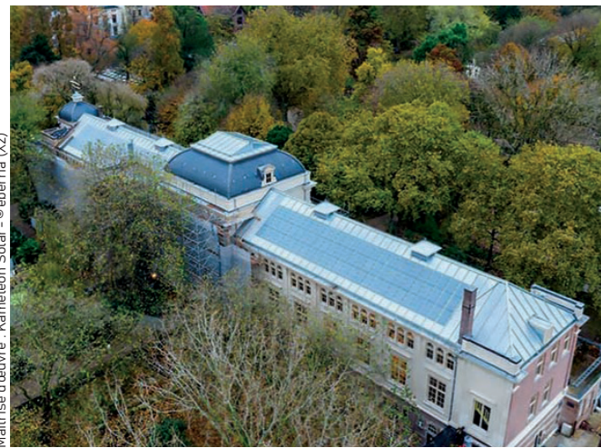
Projet De Volharding : Les panneaux photovoltaïques imitent le zinc sur la toiture historique et sont peu visibles. 156 panneaux représentant une surface de 160 m 2 ont été conçus, fabriqués et colorés dans une couleur zinc ressemblant à celle du toit.
