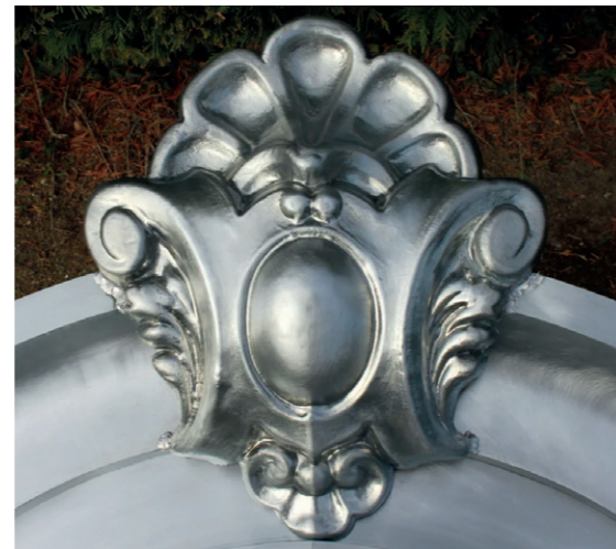
Ci-contre : la malléabilité d'une feuille de zinc fait qu'elle peut être facilement façonnée avec les outils appropriés, voire même à la main. Ci-dessus : on peut obtenir des détails très fins dans la sculpture du zinc.
