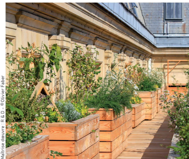
Les bacs de plantes sont la partie la plus lourde de la structure. Ils pèsent 500 kg/m 2 et couvrent 50% de la surface de la plateforme.
