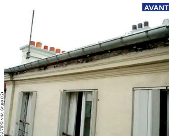
18 rue Caffarelli (3 e arrondissement) avant rénovation de la toiture : la gouttière repose directement sur la corniche.
