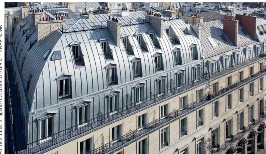
La toiture à l'impériale de l'hôtel Regina, situé dans le 2 e arrondissement, dont la couverture cintrée tout en zinc incorpore sur ses pentes des lucarnes rentrantes et des balconnets en plomb.
