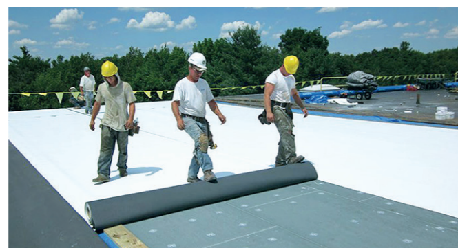
Pose d'une membrane synthétique réfléchissante.
