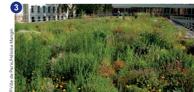
3 Strate semi-intensive, sur le toit de l'école Lacordaire (15 e ). La végétalisation est un mélange d'espaces gérés et libres, de type prairie et platebandes fleuries. Végétation mêlant plantes horticoles, plantes vivaces, graminées, petits arbustes, peu à moyennement exigeantes en eau. Substrat continu ou en bacs et jardinières, dont l'épaisseur est comprise entre 10 et 30 cm. Charge induite : 150 à 350 kg/m 2 .
