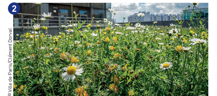
2 Strate semi-naturelle, sur le toit d'un immeuble avenue de la Porte d'Ivry (13 e ). Végétation naturelle, avec une majorité de plantes vivaces rustiques, peu exigeantes. La composition du substrat se rapproche de sols naturels. Son épaisseur est comprise entre 10 et 30 cm. Charge induite : 150 à 350 kg/m 2 .
