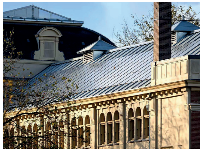
Projet De Volharding : Les panneaux photovoltaïques imitent le zinc sur la toiture historique et sont peu visibles. 156 panneaux représentant une surface de 160 m 2 ont été conçus, fabriqués et colorés dans une couleur zinc ressemblant à celle du toit.
