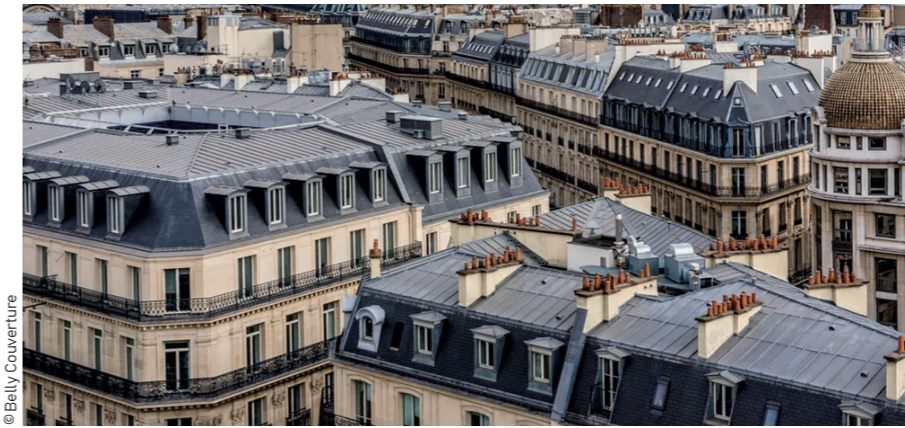
Vue aérienne de toitures à la Mansart, avec brisis en ardoise et terrassons en zinc, typiques des toitures haussmaniennes. Le brisis est la partie pentue avec les fenêtres et le terrasson, la partie la plus plate avec les cheminées.
