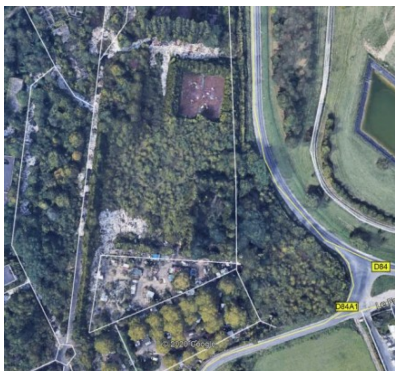
Figure 5 bis : image Google Earth du centre du site (source : Réponse à la demande de pièces manquantes)
