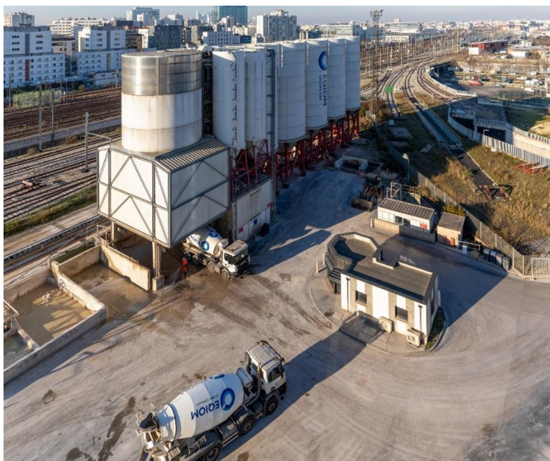
Figure 19 : Photographie d'une centrale à béton d'Île-de-France (source photo. E. Fromentin – UNICEM).
