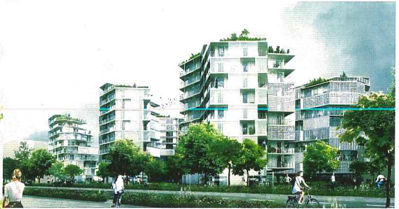
330 logements en accession et logements sociaux, équipement Petite Enfance et commerces Opérateur : Sogeprom Architecte : Hamonic et Masson Livraison : 2017
