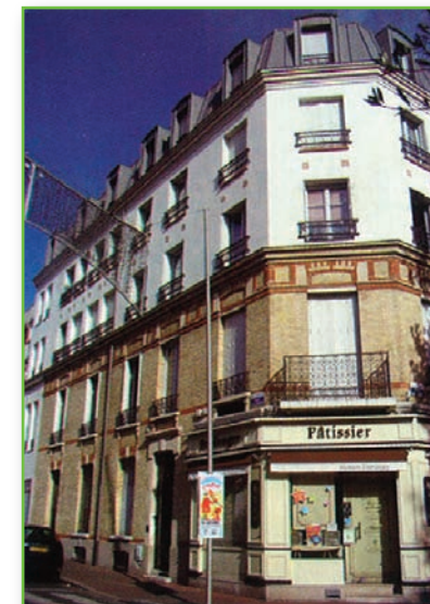
Le Vésinet, immeuble surélevé par densification verticale
