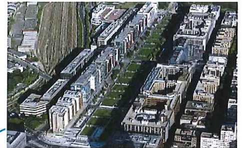
Vue contemporaine des Terrasses depuis le nord - Source : Etude d'impact / Volet Etat initial p 27
