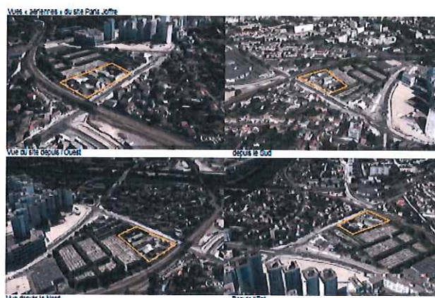
Fig 3 Vues aériennes sur l'emprise du projet (source : étude d'impact)
