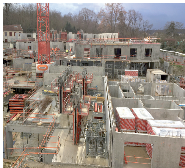
Le chantier au mois de février 2016
