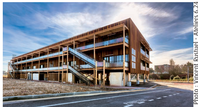
Les bureaux du pressoir du Havre (76), immeuble de bureaux biosourcé et démontable.
