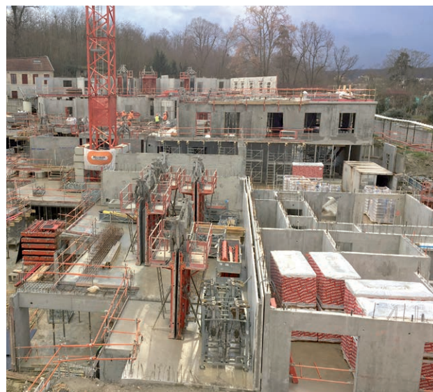
Le chantier au mois de février 2016
