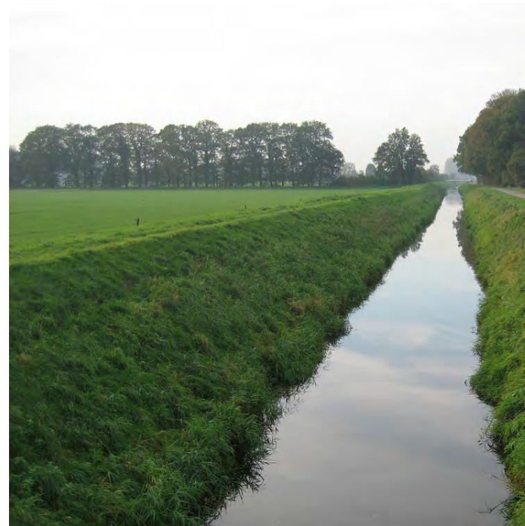
Fossé en eau
