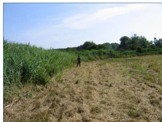
Figure 62 : Vue de l'endiguement de l'Yerres à Bernay Vilbert hauteur de plus d'1 m (Source : Fédération de pêche de Seine et Marne)
