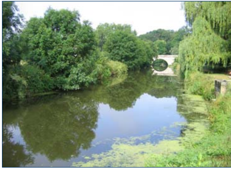
Figure 64: Vue en amont du barrage de Chaumes (faciès profond) (Source : fédération de pêche de Seine et Marne)
