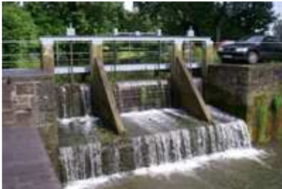
Les anciens ouvrages de moulin
