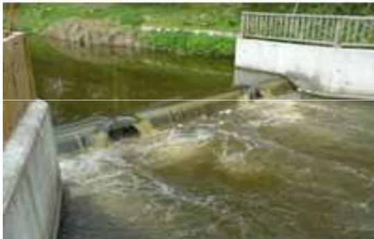
Les ouvrages de régulation hydraulique
