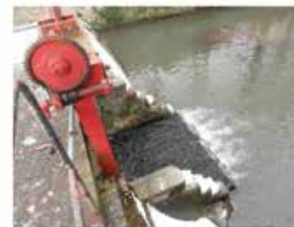
Vanne rive gauche avant travaux
