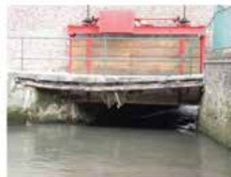
Vanne rive droite avant travaux
