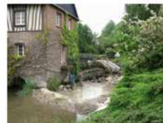
Isolement hydraulique du chantier
