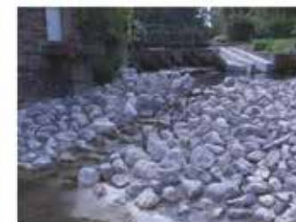
Rampe en enrochements avant la mise en eau
