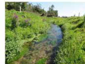
Cours d'eau restauré, deux mois après travaux
