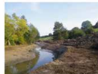
Terrassement du nouveau lit
