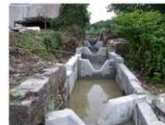
Phase travaux : réalisation des bassins
