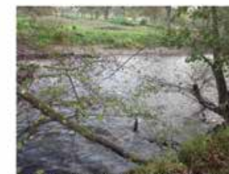
Ancienne retenue 24 heures après travaux : radier frayère-nurserie type saumons et reprise transit sédimentaire
