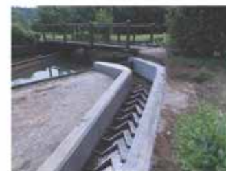
Passe à ralentisseurs avant la mise en eau
