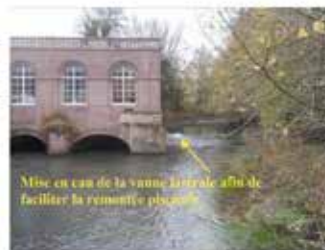
Vue de l'aval après travaux
