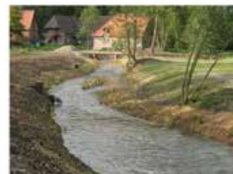
Après aménagement (partie aval du bief)
