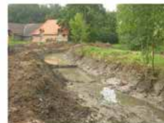
Phase travaux : reprofilage du bief
