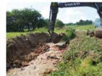
Phase travaux : suppression du seuil
