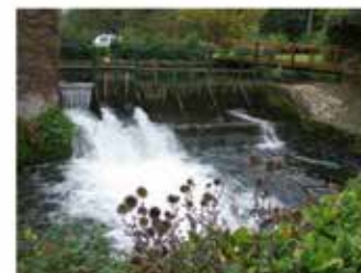
Ouvrage avant aménagement
