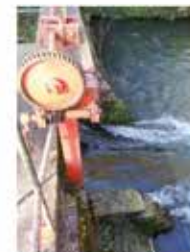
Vanne rive gauche après travaux
