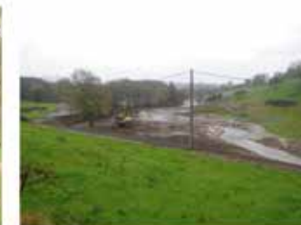
Travaux de finition
