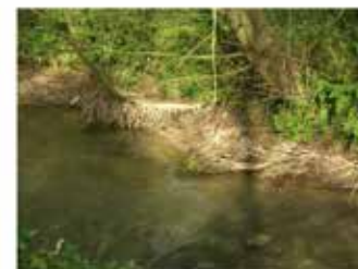
Aval du bief dénuyé
