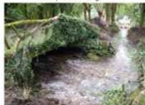
Seuil après Aménagement
