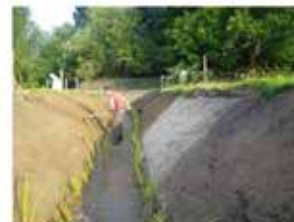
Travaux de végétalisation des berges
