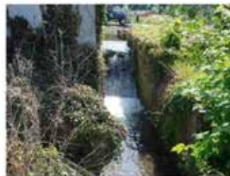
Ancien coursier avant travaux
