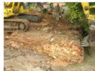
Phase travaux : suppression du seuil
