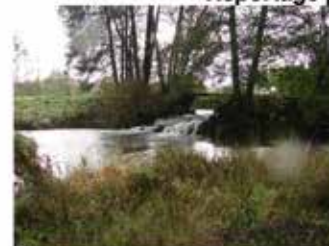
Chute avant travaux
