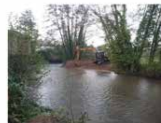
Fin de chantier par l'aval
