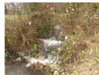
Seuil avant dérasement
