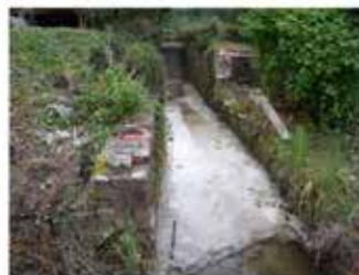
Semelle béton devant recevoir les bassins
