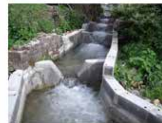
Après aménagement (vue vers l'amont)
