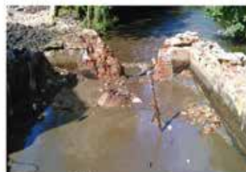
Démolition du bâtiment de la turbine
