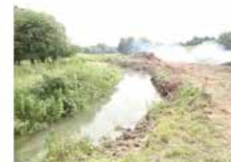
Etat du bief avant dérasement
