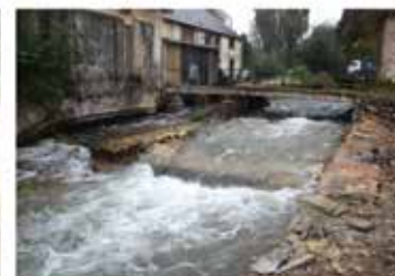
Démolition du déversoir
