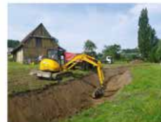
Terrassement du nouveau lit
