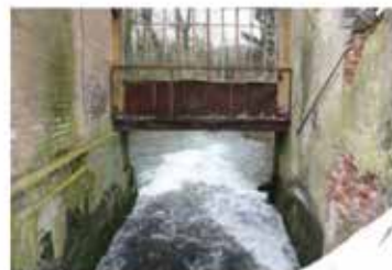
Seuil vue de l'amont
