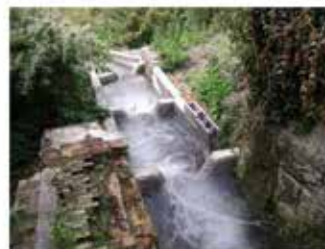
Après aménagement (vue vers l'aval)
