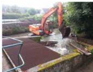
Vue des travaux
