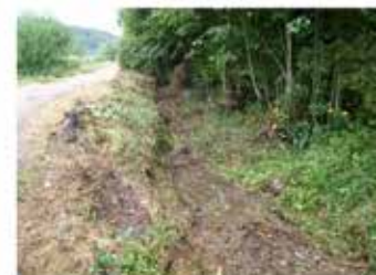
Bras amont avant travaux
