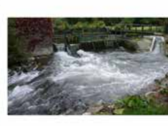
Ouvrage après aménagement
