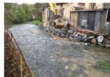
Pose des blocs en berge
