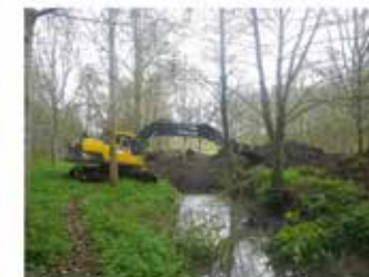
Comblement de l'ancien bief
