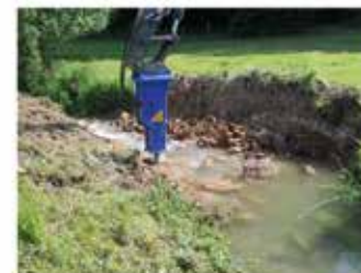
Phase travaux : démolition du seuil
