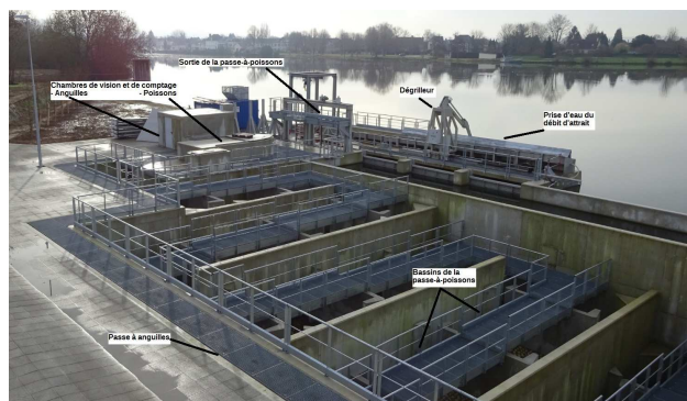
Illustration 2: Vue générale amont de la passe réalisée
