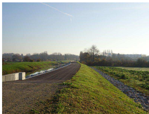
Déversoir de la digue du Labourat
