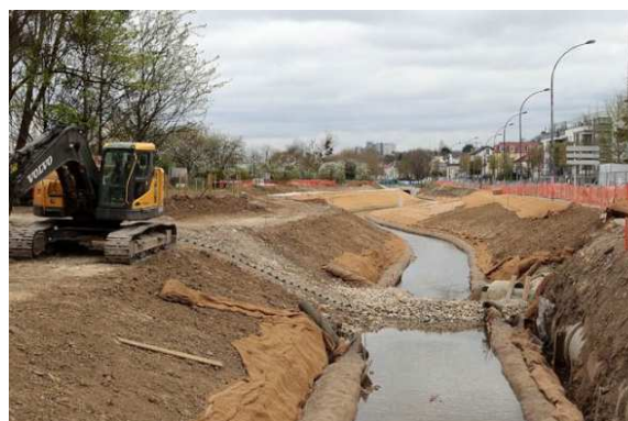
Travaux de réouverture à L'Haÿ-les-Roses
