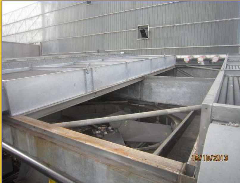
Retrait des batteries et mise en place des nouvelles batteries avec les vannes sortie condensats, les purges et les tuyauteries d'équilibrage.
