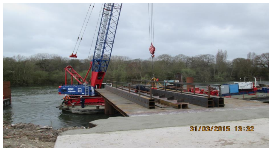
Illustration n°3 – Etapes de la création du quai de déchargement fluvial
