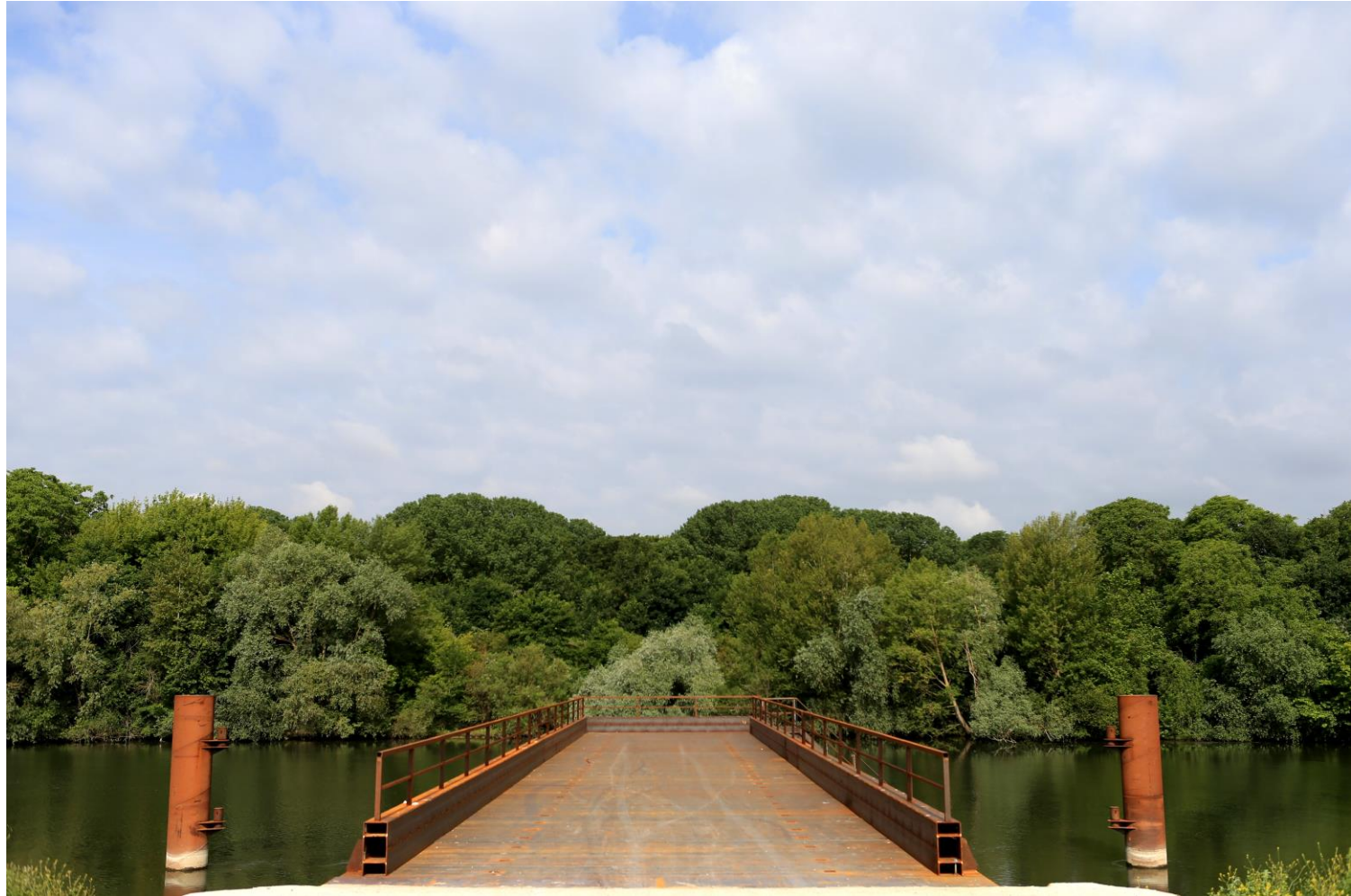
Illustration n°4 – Quai de déchargement fluvial réalisé
