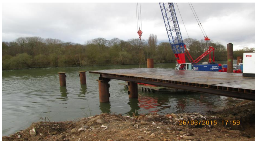
Illustration n°3 – Etapes de la création du quai de déchargement fluvial
