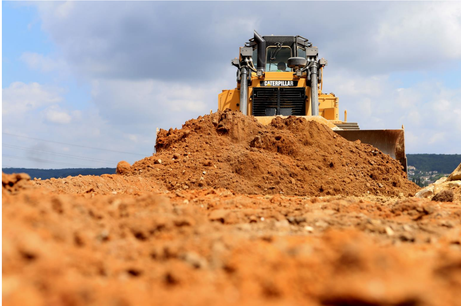
Illustration n°7 – Mise en remblais des apports
