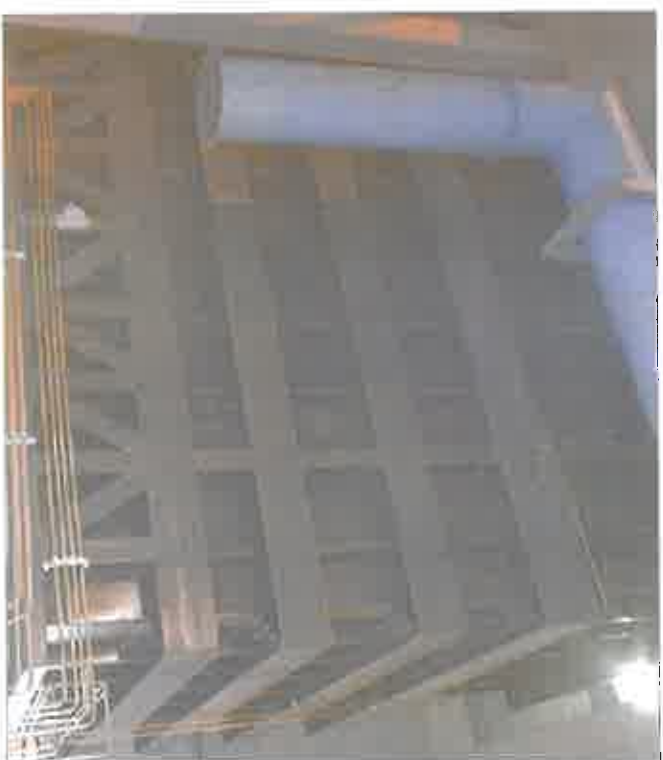
Silo à boues
