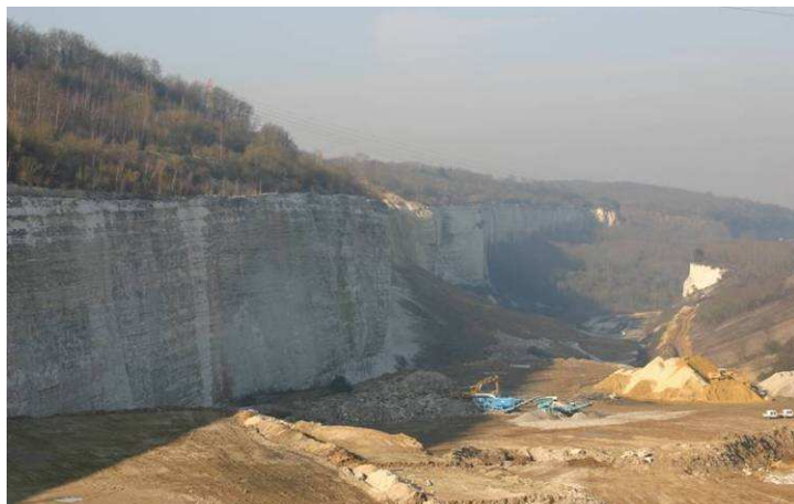
Remblaiement progressif de la carrière et unités de recyclage de matériaux - © Biotope, 2008
