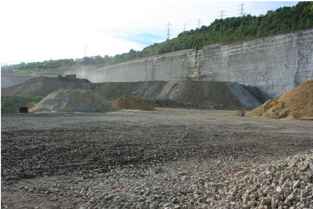
Remblaiement de la carrière et création progressive des terrasses - © Biotope
