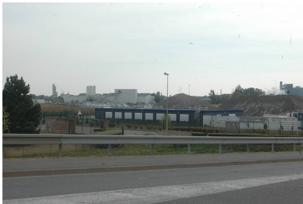
Photo 5 : Vue de la Zone industrielle de Montereau (crédit : Christophe Parisot)
