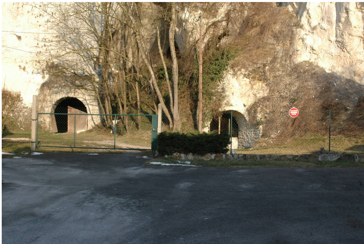
Photo 19 : Clôture et portail d'entrée (crédit Christophe Parisot)
