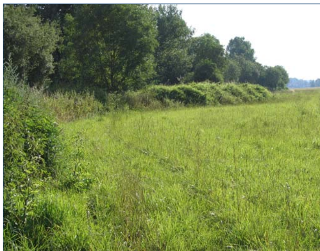
Figure 35 : Vue d'une digue (plus de 1 m de haut) (Source : Fédération de Pêche de Seine-et-Marne)
