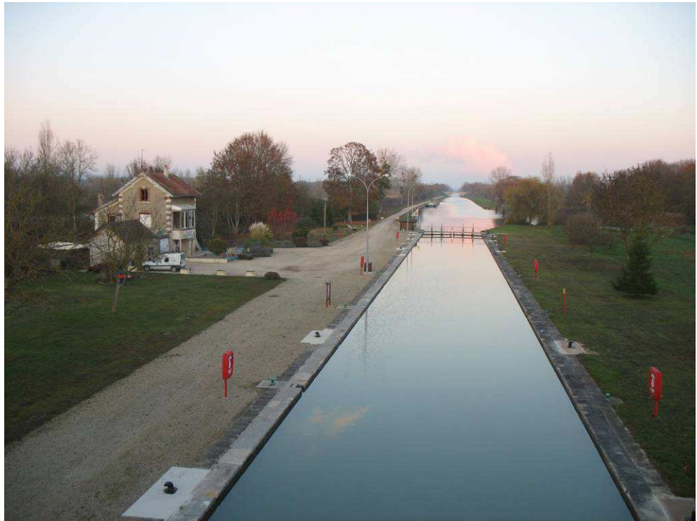
Écluse à l'entrée du canal de Beaulieu (© Biotope, S. Durot)
