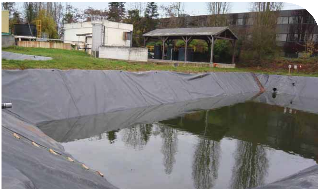
SIG à Plaisir (78) - Bassin de confinement destiné à recueillir l'ensemble des eaux susceptibles d'être polluées lors d'un accident ou d'un incendie, y compris les eaux utilisées pour l'extinction. Ce bassin a été réalisé en 2009 en conformité avec l'arrêté ministériel de 30 juin 2006 relatif aux installations de traitement de surface.
