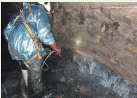
Nettoyage de la galerie souterraine (source Ademe)
