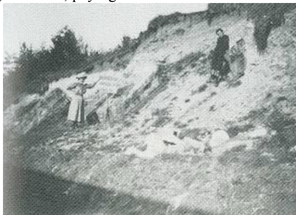
Carrière de sable à Ormoy-la-Rivière (1908), vers le sud ouest Photo : coll. Schneid. In, Ormoy-la-Rivière un village de l'Etampois . DE WEVER P. et MJ. : DUCLOS JL. 1990. ISBN 011173.
