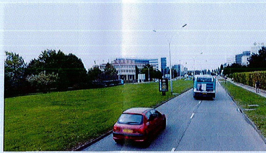
VUE 2: AVENUE M. SAULNIER. Photo datant de juillet 2011 (avant travaux tramway)
