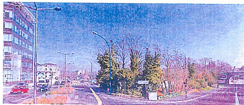
Vue de la chaufferie depuis la rue Victor Basch
