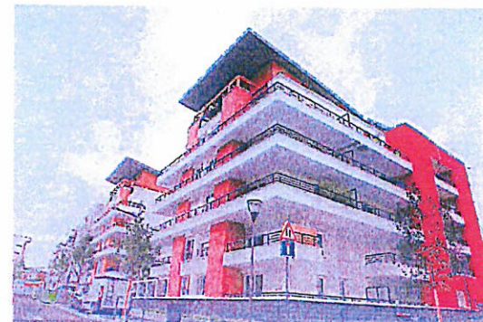
Vue sur les nouveaux logements en bordure de site
