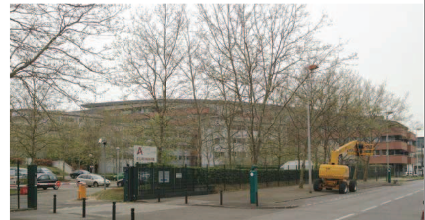
Photo 05 : VUE sur le Boulevard des chênes. Prise de vue: JUIN 2012
