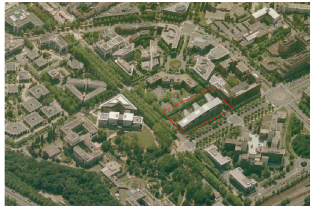
VUE D'ENSEMBLE (ANGLE NORD-OUEST)
