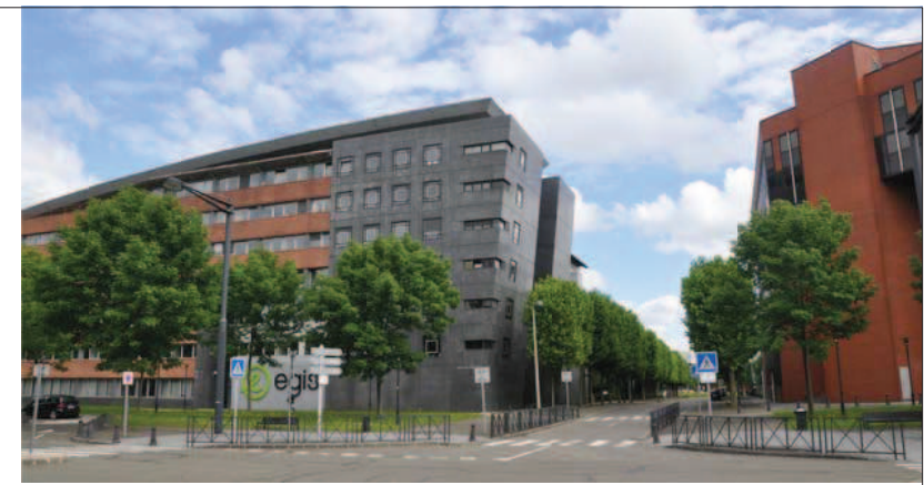
Photo 03 : Vue à l' ANGLE De l'Avenue du Centre et rue Emile et Charles Pathés. Prise: JUIN 2012
