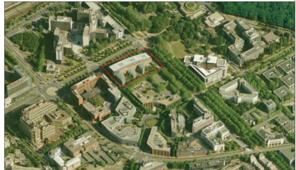
VUE D'ENSEMBLE (ANGLE SUD-EST)
