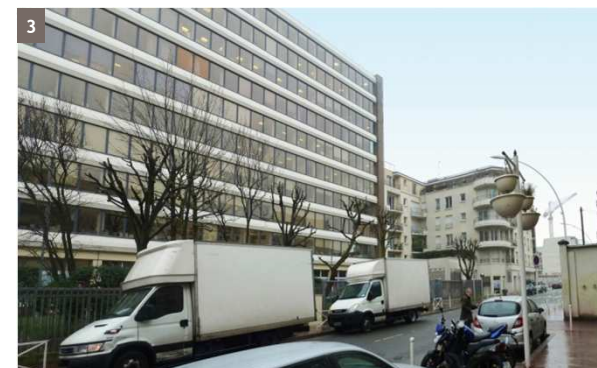
Bâtiment A et Immeuble de logements voisin
