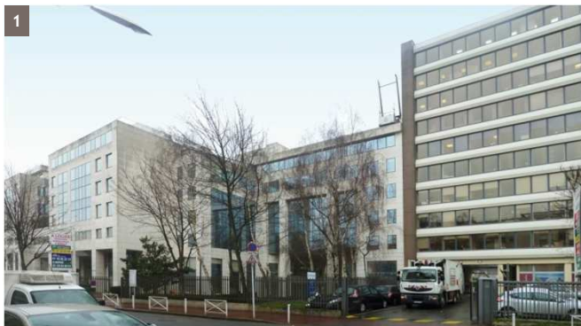
Ensemble immobilier de bureaux voisin et Bâtiment A Intérieur de la parcelle
