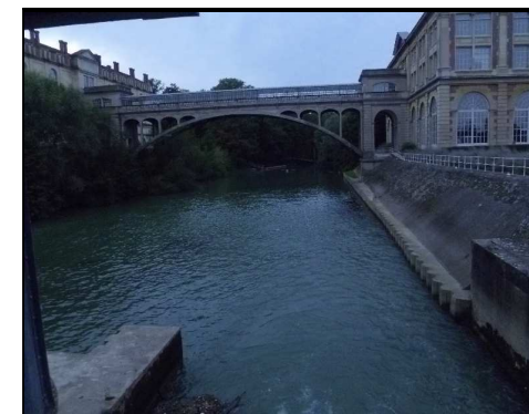
Photographies n° 8 : vue aval du site
