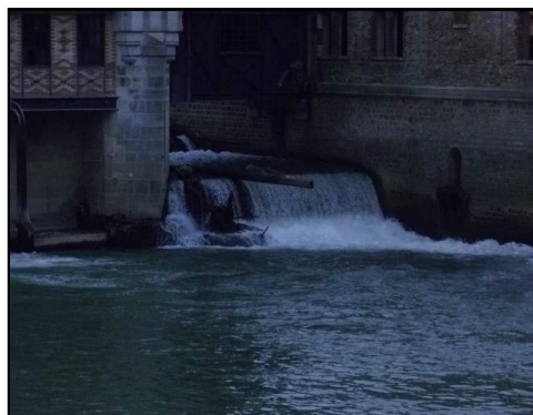
Photographie n° 6 : vue aval du déversoir en rive gauche
