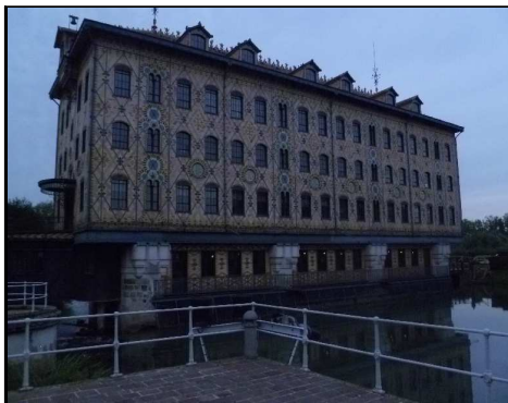
Photographie n° 1 : vue amont du site
