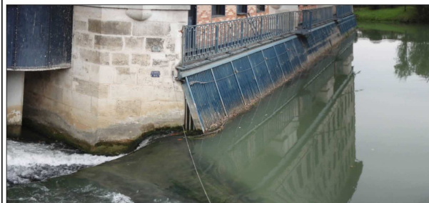
photographie n°3 - Amont de l'ancien moulin ; déversoir en rive gauche
