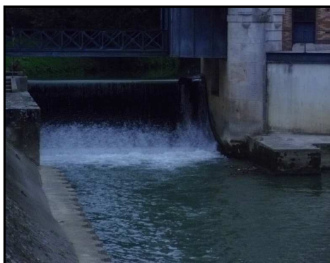
Photographie n° 4 : vue aval de la chute d'eau en rive droite de la chocolaterie
