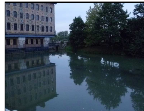
Photographie n° 2 : vue amont du lieu d'implantation de la turbine en rive droite
