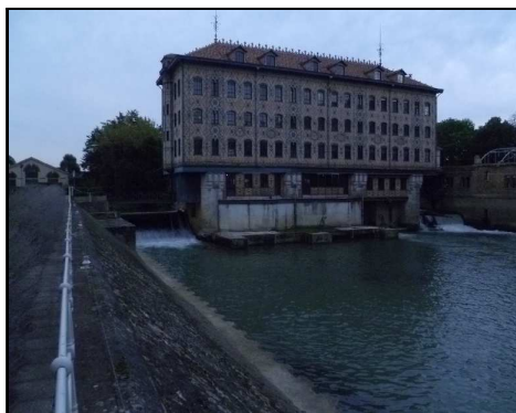
Photographie n° 7 : vue aval du site d'implantation
