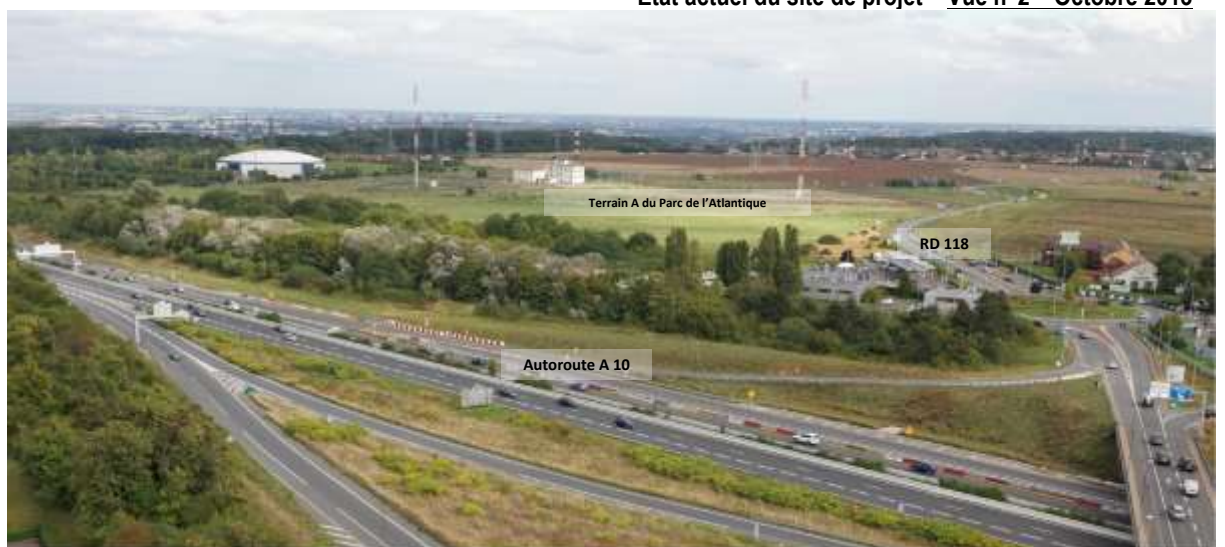
VUE AERIENNE OUEST COTE AUTOROUTE A10
