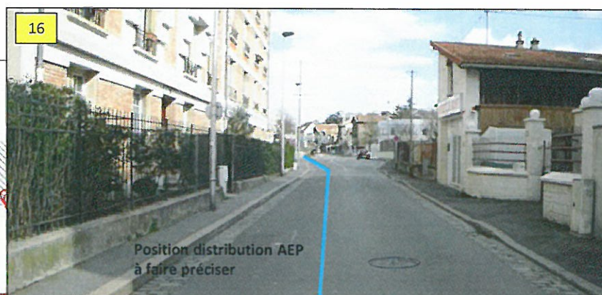
Rue des Berthauds: 2 voies de circulation, double sens, caniveaux pavés chaussée < 6 m de large : nécessaire de fermer complètement la rue pendant les travaux
