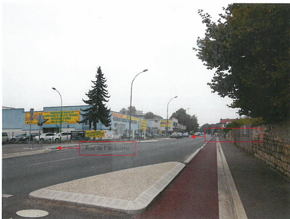
Photo 5 : entrées des rue Louis Armand et de l'Industrie
