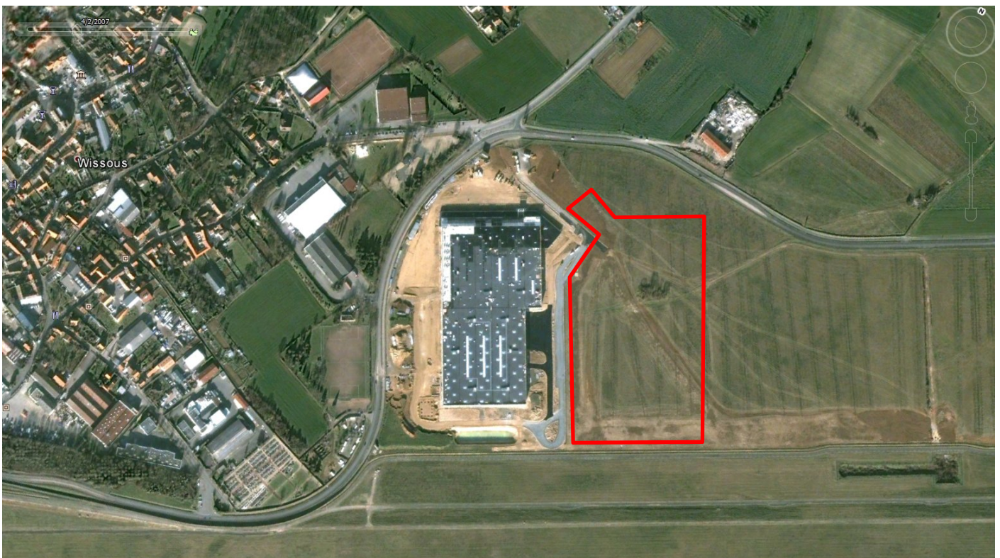
Février 2007 : Construction de la plateforme de la Poste
