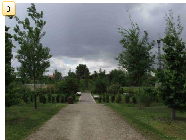
Vue vers le Sud. Les derniers aménagements réalisés sont différents de ceux de la section courante (pavés, mobiliers). Le cheminement s'interrompt en limite du bassin contigu aux emprises RFF
