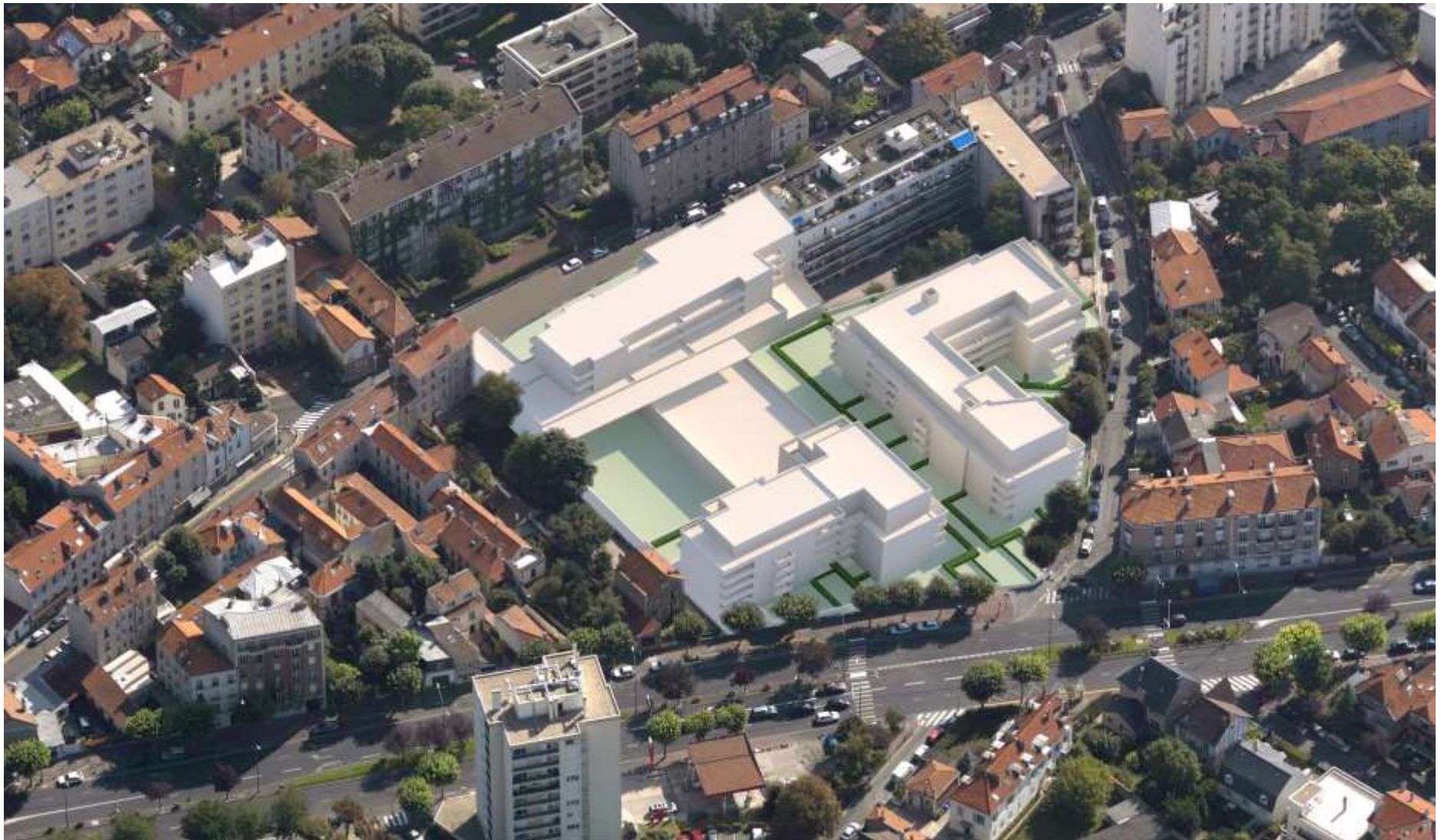
Vue lointaine - Photo 1
