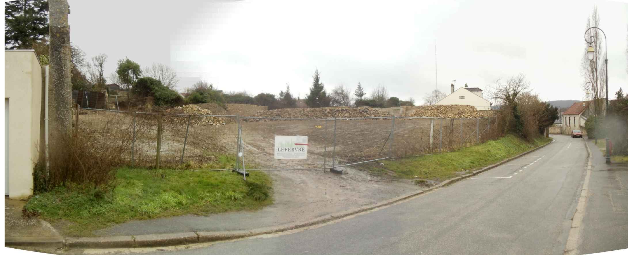
Photo 01 - Vue depuis l'entrée
