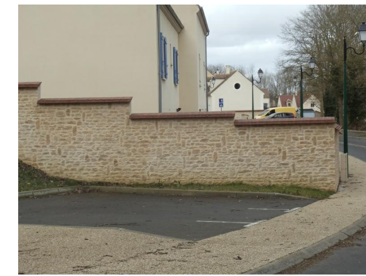
Mur en pierre
