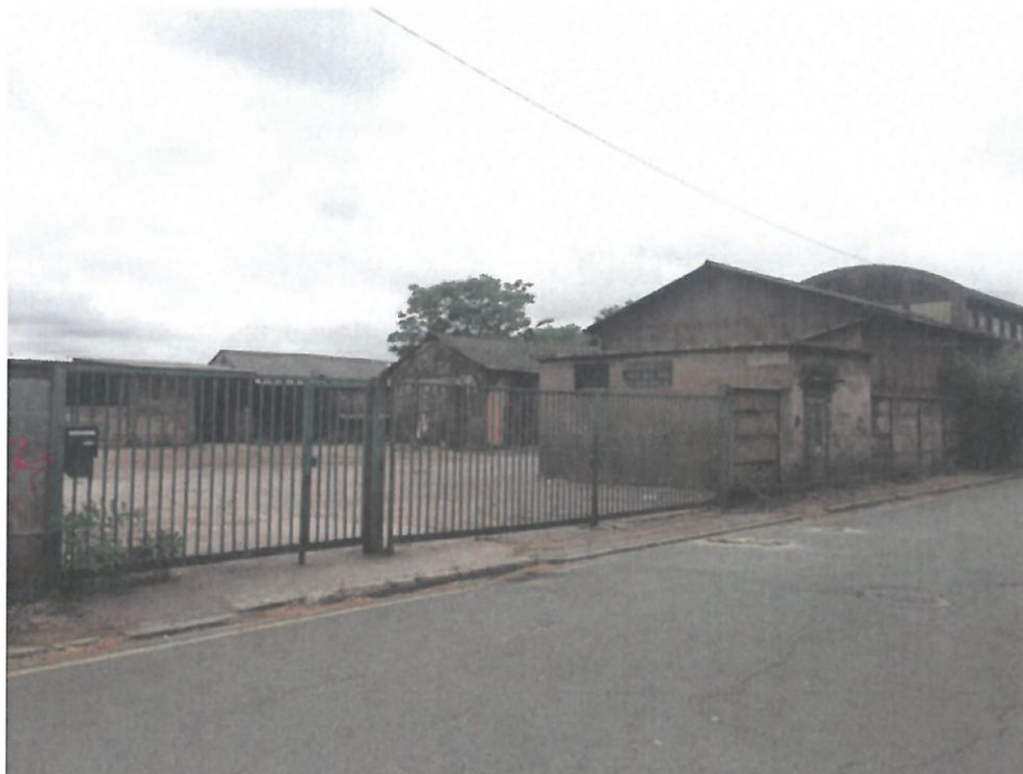
Photographie 13 : Vue des bâtis le long de la rue Piquenard
