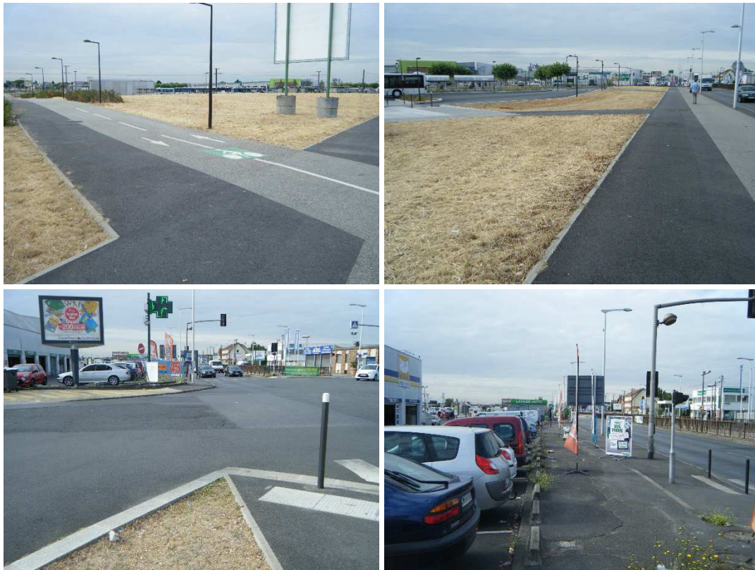
Vues de l'extrémité Nord du tracé
